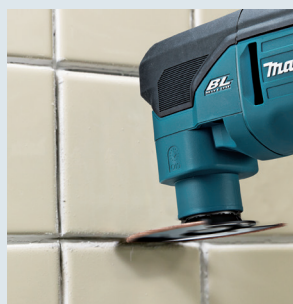
Rimozione delle fughe dalle piastrelle
