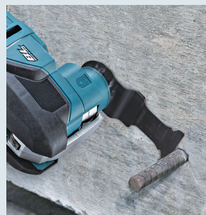
Taglio a filo dei tondini di armatura
